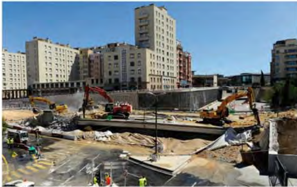
bd Leclerc en chantier - vue vers gare S' Charles
