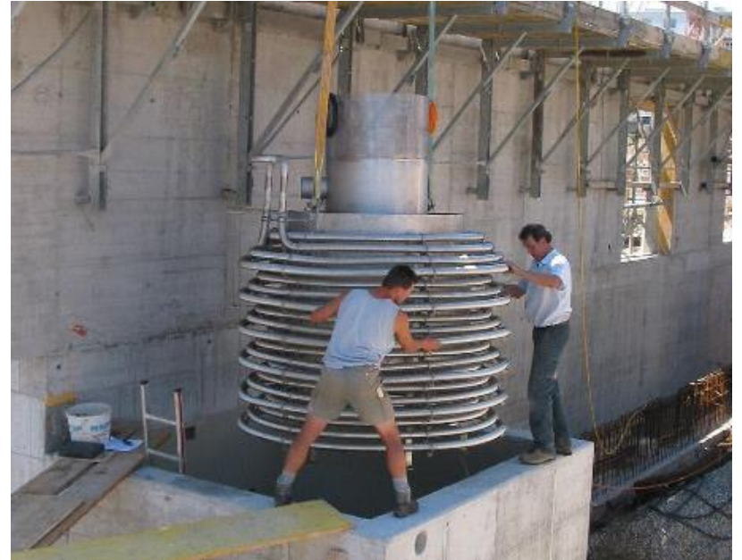
Récupération de la chaleur des eaux usées
