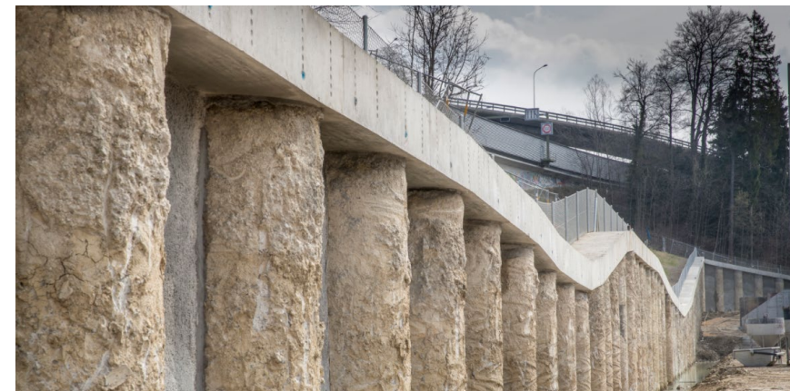
Blindage en paroi de pieux forés : 871 kg CO 2 eq /m 2 de paroi
