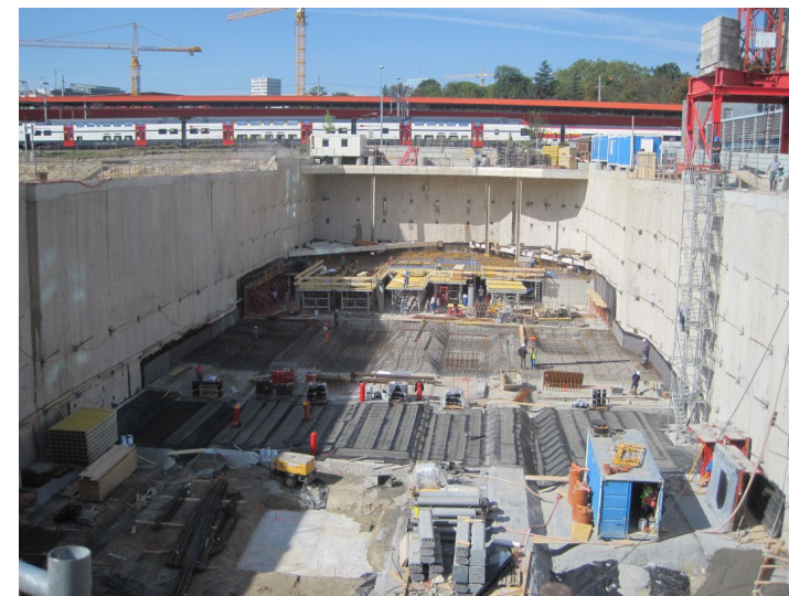
Excavation, blindage et structure souterraine : 5-15% du bilan carbone
