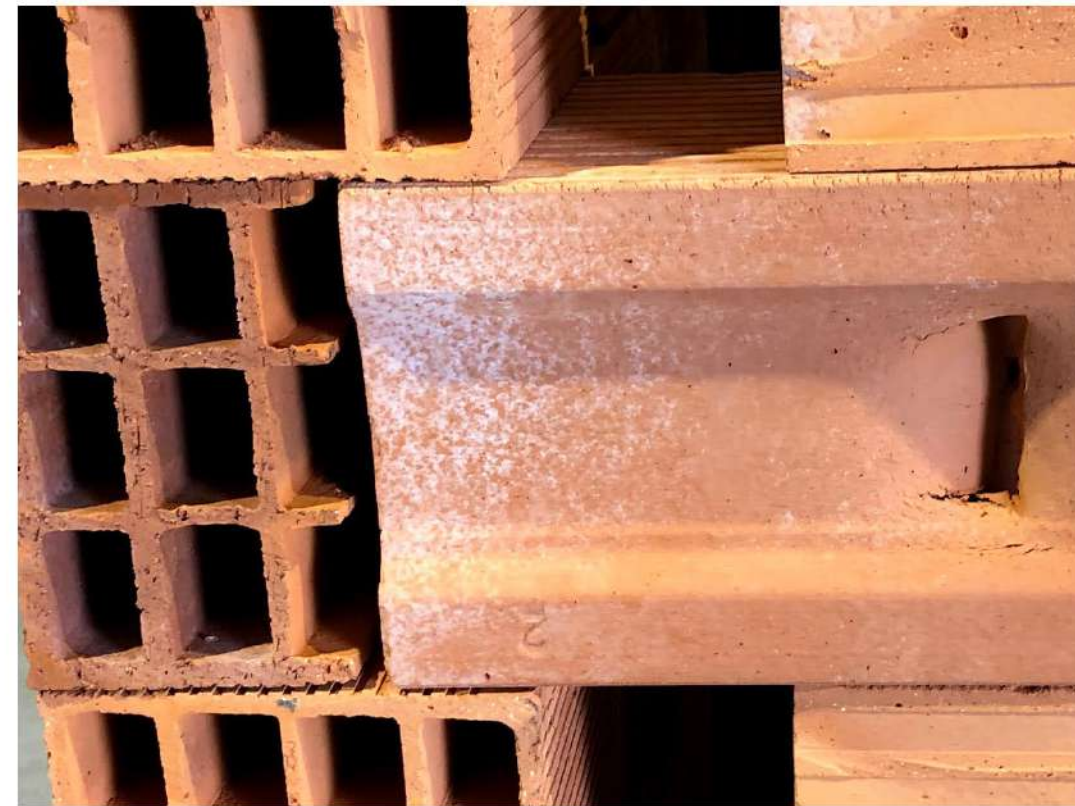
Les briques harponnées seront cimentées avec une couche épaisse pour garantir le maintien avec le mur structurel
