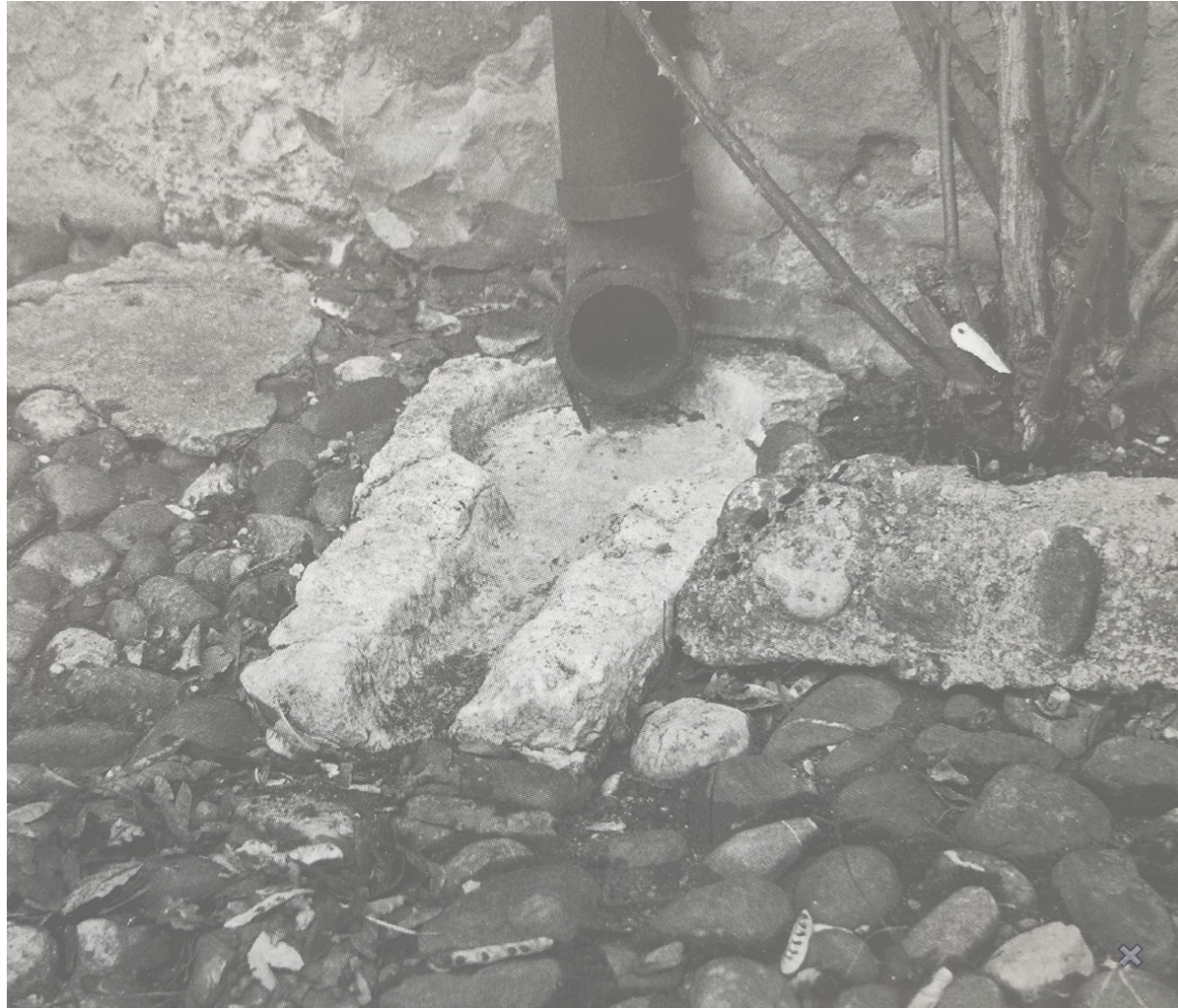
↑ Petit-Saconnex, descente en fonte et pierre calcaire
