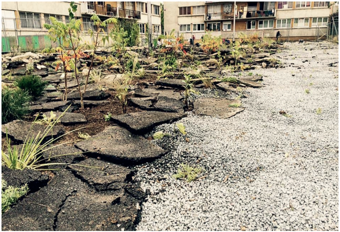
Tout garder : Jardin des Joyeux à La Maladrerie, Aubervilliers. L’intervention porte sur un parking à l’abandon de cette cité-jardin des années 1980, dont la couche d’enrobé a été cassée en 2015 pour empêcher tout accès aux véhicules motorisés. Dans l’attente d’un nouveau projet urbain, Wagon Landscaping transforme en cinq jours de chantier ce chaos en un jardin de rocaille géant de 1600 m 2 – dans la tradition des jardins alpins du 19 e siècle, avec 150 espèces de plantes. (YANN MONEL)
