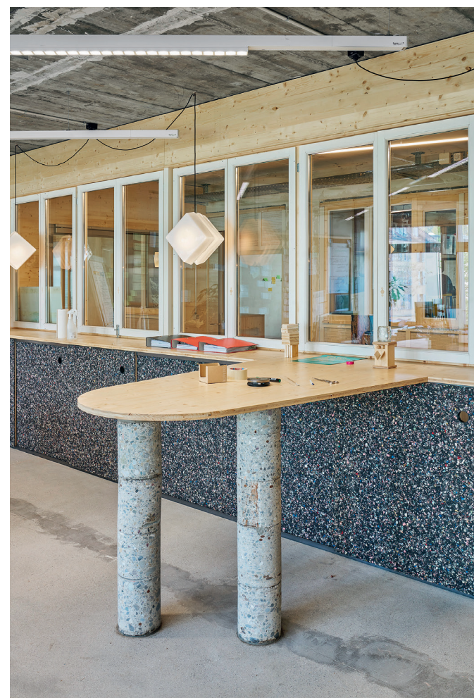
Des toilettes au bureau : les losanges blancs deviennent des lampes suspendues uniques en leur genre. Les fenêtres à coulisses des armoires sont des déchets plastiques réemployés.
