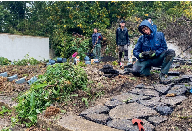
Réemployer : Jardin Casse Dalle, Cité maraîchère, Ville de Romainville, 2022. Désimperméabilisation et aménagements pour permettre la pratique de l’agriculture urbaine dans une friche. (YANN MONEL)
