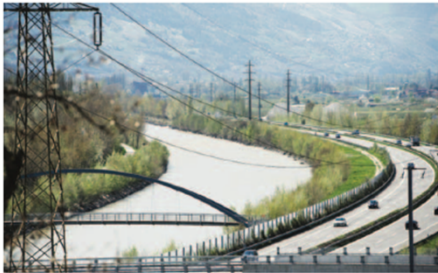
Ainsi que la gauche et les Verts mettent en avant un fleuve gubère différent d'une «autoroute d'eau», la droite a mis l'accent sur la sécurisation des infrastructures. ANJA BUELA
