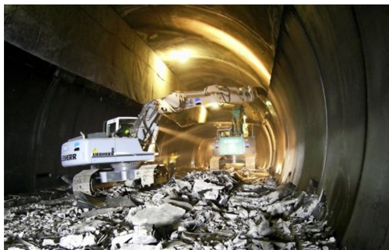
Travaux d'assainissement en 2004-2005. Bureau d'ingénieurs BG Ingénieurs-Conseils SA. BG INGÉNIEURS-CONSEILS SA
