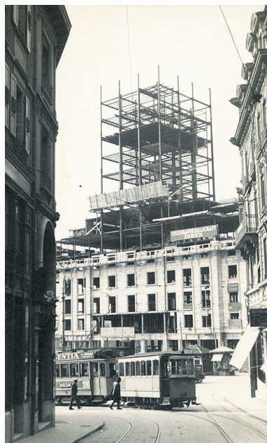
La tour Bel-Air de Lausanne en construction. ARCHIVES DE LA CONSTRUCTION MODERNE-EPFL, DOSSIER ZWAHLEN MAYR
