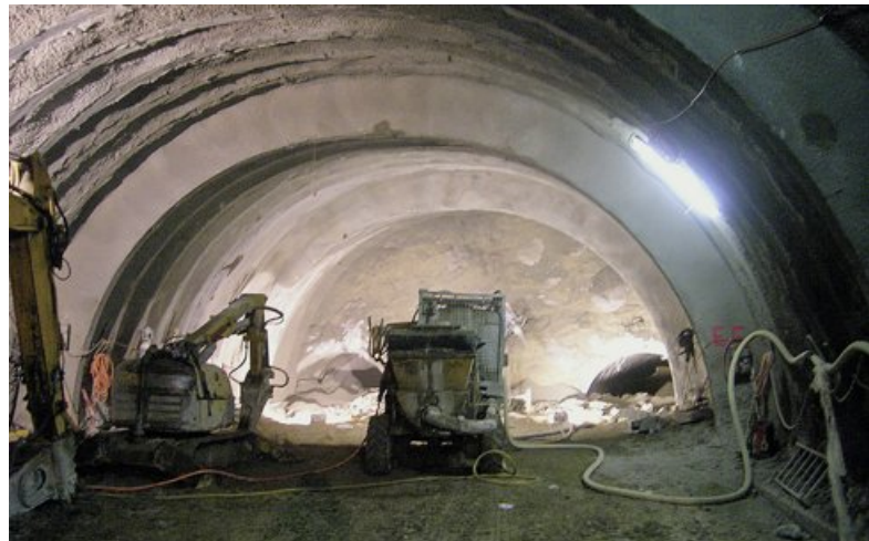
Construction du tunnel de Langallerie. Bureau d'ingénieurs Norbert SA Géologues-Conseils. NORBERT SA GÉOLOGUES-CONSEILS
