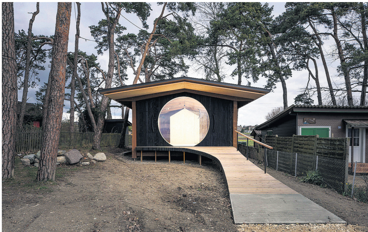
La Maison de l'île aux oiseaux, LOCALARCHITECTURE. Av. de la Plage 49, Prévèrenges. En 2016, le Cercle ornithologique de Lausanne a acquis un petit cabanon situé en face de l'île aux oiseaux à Prévèrenges, un biotope artificiel gagné sur le lac et classé réserve naturelle. La bâtisse a pour vocation de sensibiliser la population à la protection de la nature et du climat. Sa structure de planches verticales assemblées sans colle qui se plient pour former une résille évoque la tension et la finesse du nid. Sa fenêtre ronde rappelle le nichoir. MATTHIEU GAFSOU
