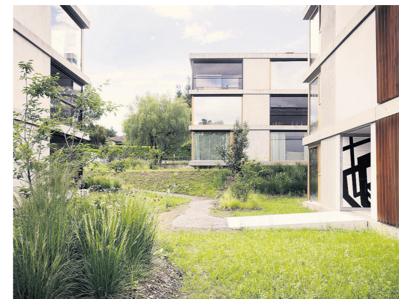
Construction d'un habitat groupé, Philippe Meyer. Chemin des Prés-Palais 6ABC, Corsier (GE).
