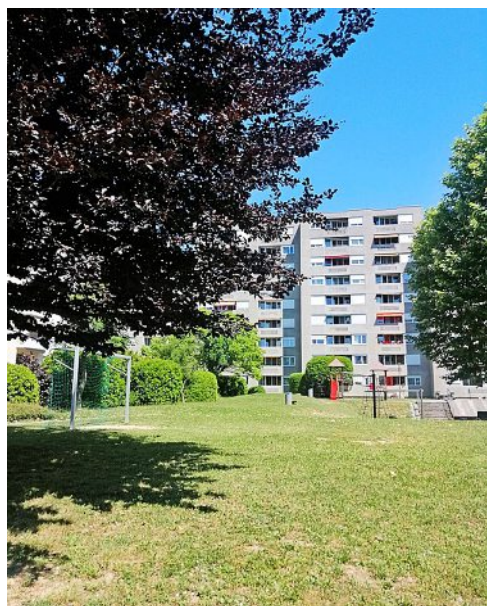
Les espaces verts et arborés contribuent à la réduction des îlots de chaleur. FM+A/2B ARCHITECTES/BRUNO MARCHAND
