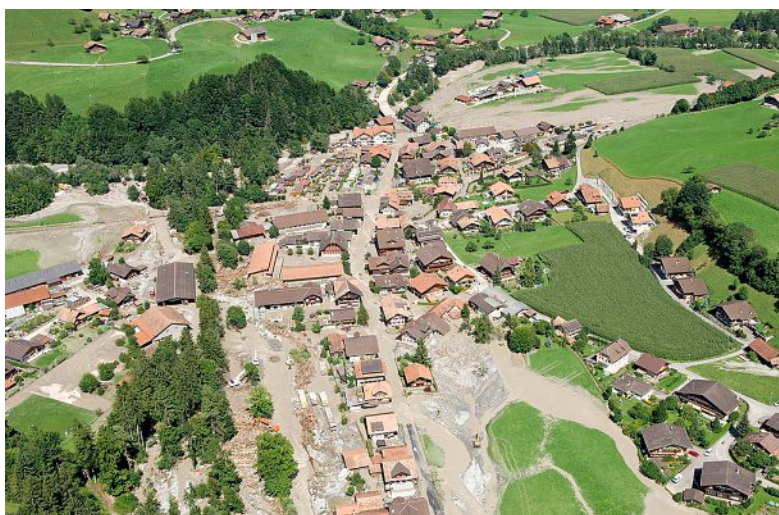
Village d'Oey-Diemtigen complètement inondé lors de la crue du 24 août 2005. EREIGNISKATASTER AMT FÜR WALD UND NATURGEFAHREN KANTON BERN
